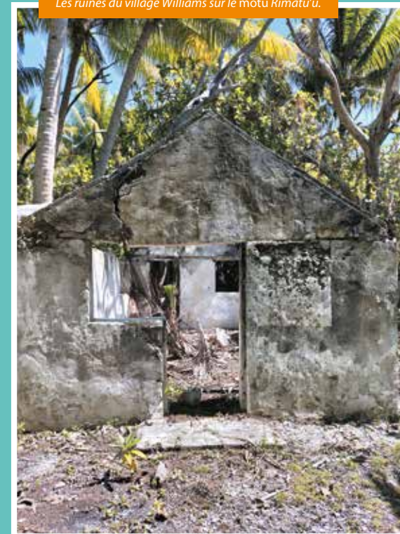
Les ruines du village Williams sur le motu Rimatu'u.
